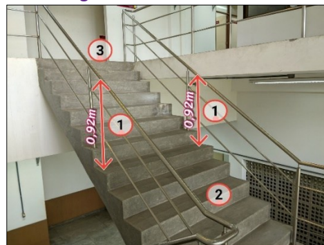
Figura 34: Escada do Bloco E
