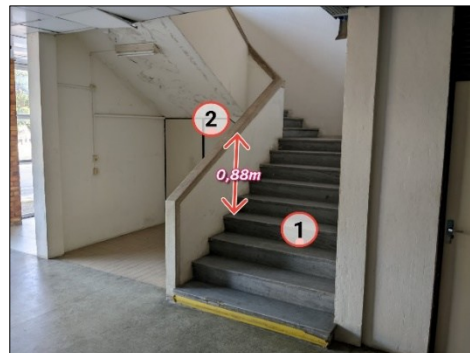
Figura 15 – Escada do Bloco A
