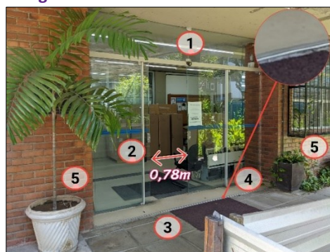
Figura 40: Porta de entrada do Bloco H
