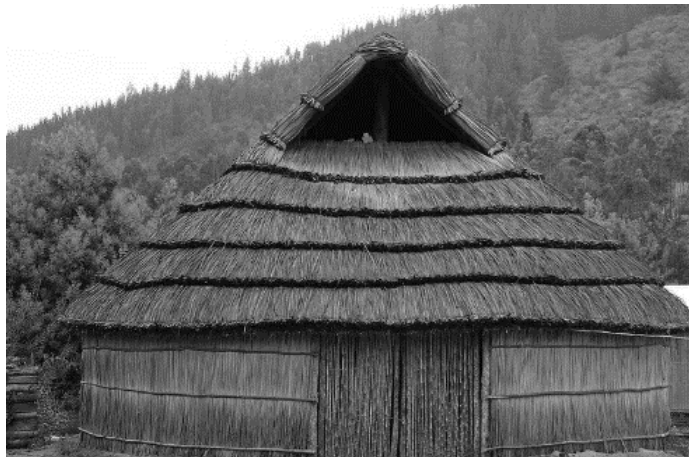
Figura 1 Fotografía de una ruka, donde se puede apreciar su relación material con el entorno natural. La materialidad es principalmente madera, barro y paja
