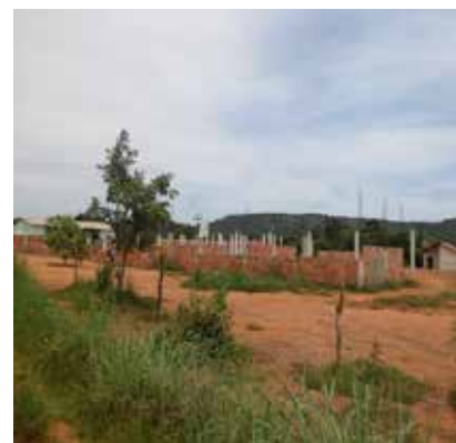
Foto 3 - Construção da futura escola da comunidade
