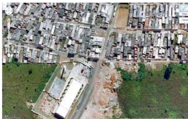
Figura 3 – Vista aérea da área do bairro onde está localizada a escola e seus arredores. Em destaque, o prédio da escola.
