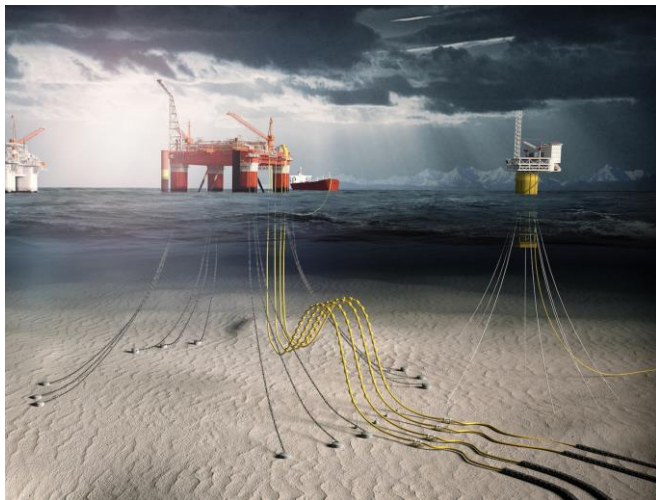
Figura 1 - Sistema offshore utilizando de risers flexíveis para conexão com poço de petróleo.
