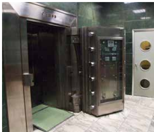
Figura 5 :: Entrada da caixa-forte (cobre). Fonte :: NC|AI, 08/12/2011.
