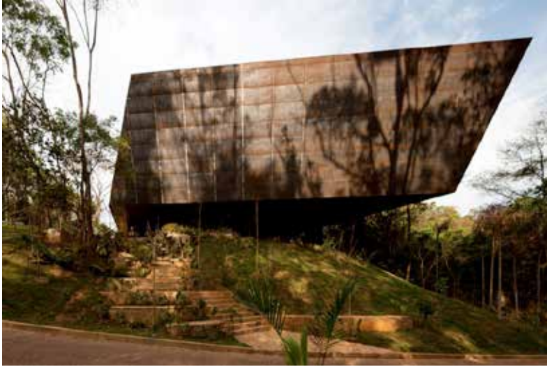
Figura 2 :: Foto externa do pavilhão do artista Miguel Rio Branco no Inhotim Fonte :: Disponível em: < http://www.archdaily.com.br/br/01-7103/galeria-miguel-rio-branco-inhotim-arquitetos-associados >. Acesso em: 1 dez. 2014.
