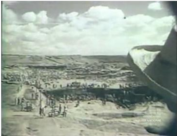
Figura 5: Trabalhador observa obra
