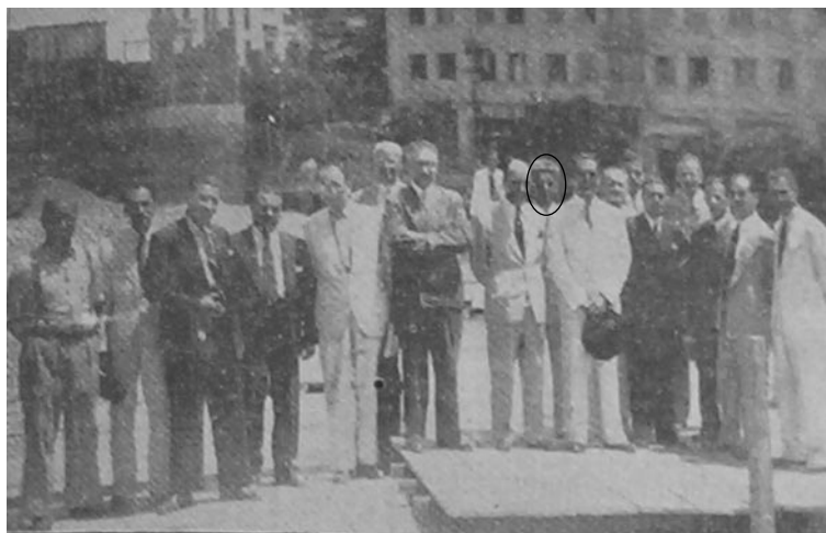
Figura 14: Comitativa de João Carlos Vital e equipe técnica das obras do Conjunto Sulamérica/Sulacap publicada no “O Estado de Minas” de 06 fev. 1942. Em destaque, Raphael Arcuri.
