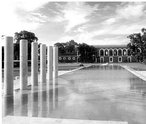
Ex hacienda Temozón, Yucatán. Reutilización en Hotel. Vista exterior. (Archivo Torres Salomao)
