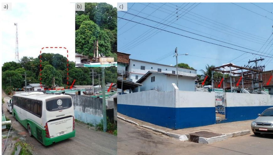
Figura 2. Unidades das UHE dentro da área urbana: a) usina termelétrica na cidade de Silves; b) coluna poluição expelida pelo grupo gerador; c) usina na cidade de Silves com os grupos geradores de contêineres destacados com seta vermelha. Fonte: Imagens do autor em 28/08/2022.
