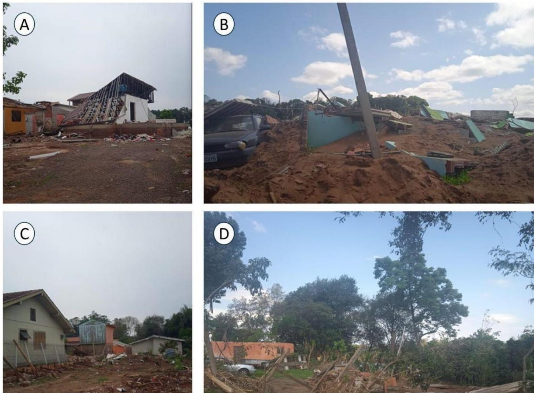
Figura 12. Registros fotográficos dos danos verificados no bairro Moinhos, Rua dos Marinheiros (Estrela, RS) após o evento de setembro de 2023. A: Residência colapsada após a inundação de setembro de 2023; B: Residência e automóvel destruídos e cobertos por areia após setembro de 2023; C: Danos nas edificações após inundação de setembro de 2023; D: Danos na edificação próximas à margem do rio Taquari após setembro de 2023. Fonte: próprio autor, 2023.
