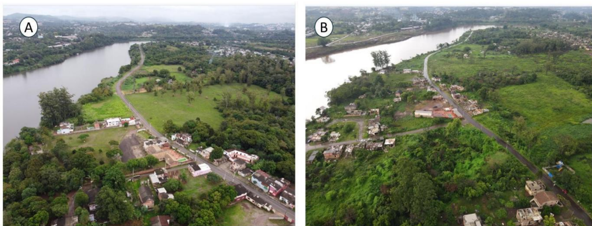
Figura 16. Registros fotográficos dos danos verificados no bairro Oriental (Estrela, RS) após o evento de maio de 2024. A: Edificações antes das inundações (março de 2023); B: Edificações após inundação de maio (dezembro de 2024). Fonte: próprio autor, 2023; 2024.
