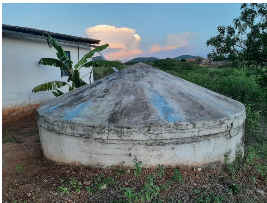
Figura 2. Cisterna de placa na comunidade Maniçoba, zona rural de Antônio Martins-RN. Fonte: Autores, 2025.
