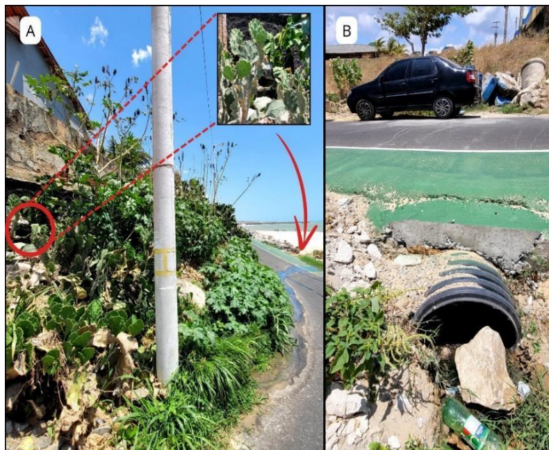
Figura 12. A) Despejo de resíduos líquidos na praia; B) Galeria pluvial despejando resíduos líquidos. Fonte: Elaboração dos autores, 2024.
