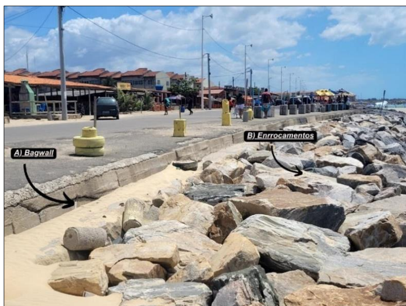
Figura 1. Estruturas de Intervenção Costeiras na Praia do Icaraí: A) Bagwall; B) Enrocamentos. Fonte: Elaboração dos autores, 2024.
