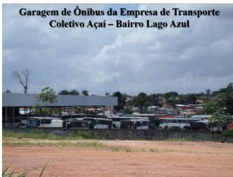
Figura 13. Instalação da Empresa de Transporte Coletivo no bairro Lago Azul. Fonte: os autores, 2017.
