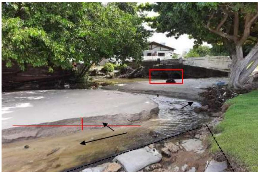
**Figura 15.** Canal de esgotamento sanitário com desembocadura na faixa arenosa da praia de Ponta de Pedras induzindo a morfologia local.
