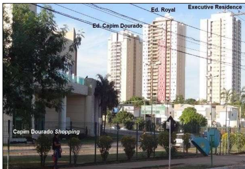
Figura 3. Edifícios nas proximidades do shopping . Fonte: Rodrigues, 2015.
