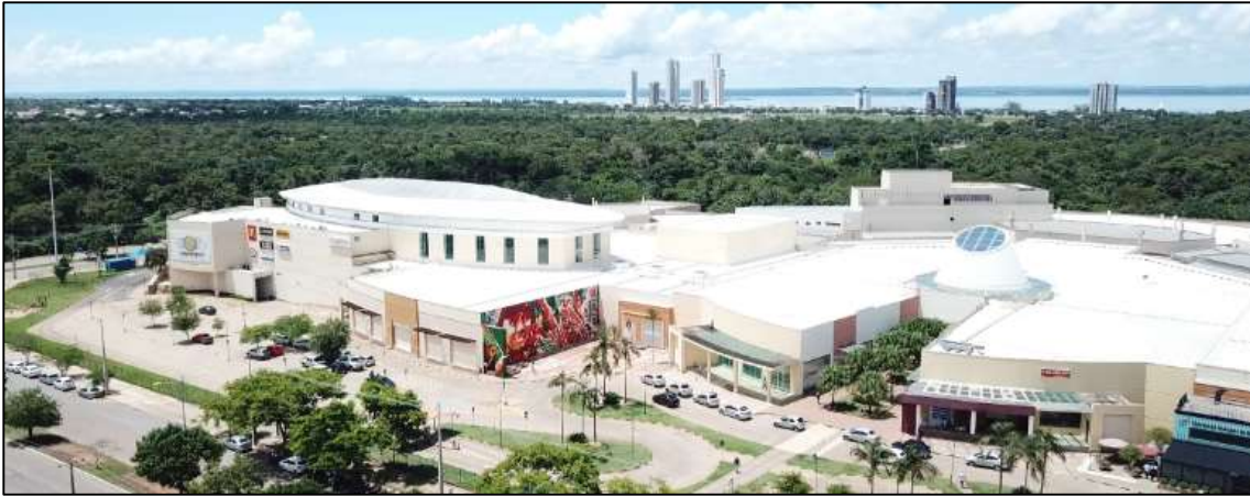
Figura 2. Vista do Capim Dourado Shopping (TO). Fonte: Capim Dourado Shopping , 2020.
