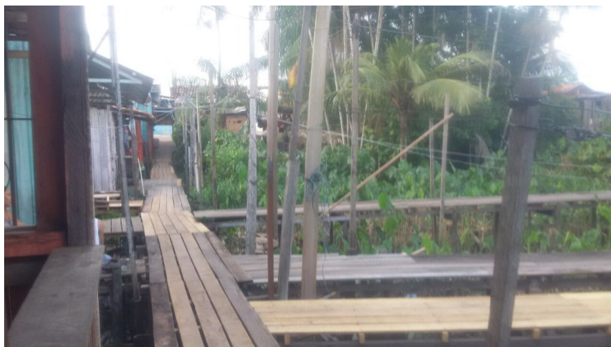
Figura 3- Ponte que dá acesso à entrada da vila Sarará. | Fonte: Geise Teles, 2020.
