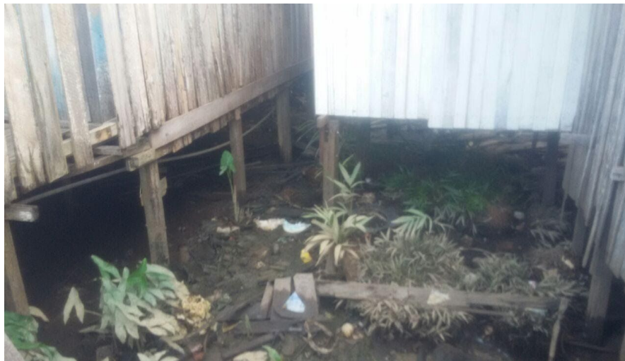
Figura 6- Lixo em área passível de enchentes. | Fonte: Geise Teles, 2020.
