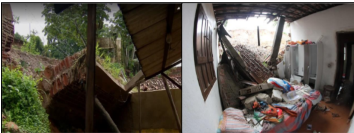
Figura 12: Deslizamento de barreira destruiu parcialmente uma residência na Unidade Residencial 07, na Várzea, no Recife no dia 16/04/2017. Fonte: http://g1.globo.com/pernambuco/videos/v/forte-chuva-no-grande-recife/4962473/
