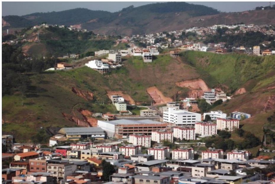
FIGURA 4: Cortes de terreno e pontos de escorregamentos no bairro Quintas da Avenida. FONTE: do autor, 2015.
