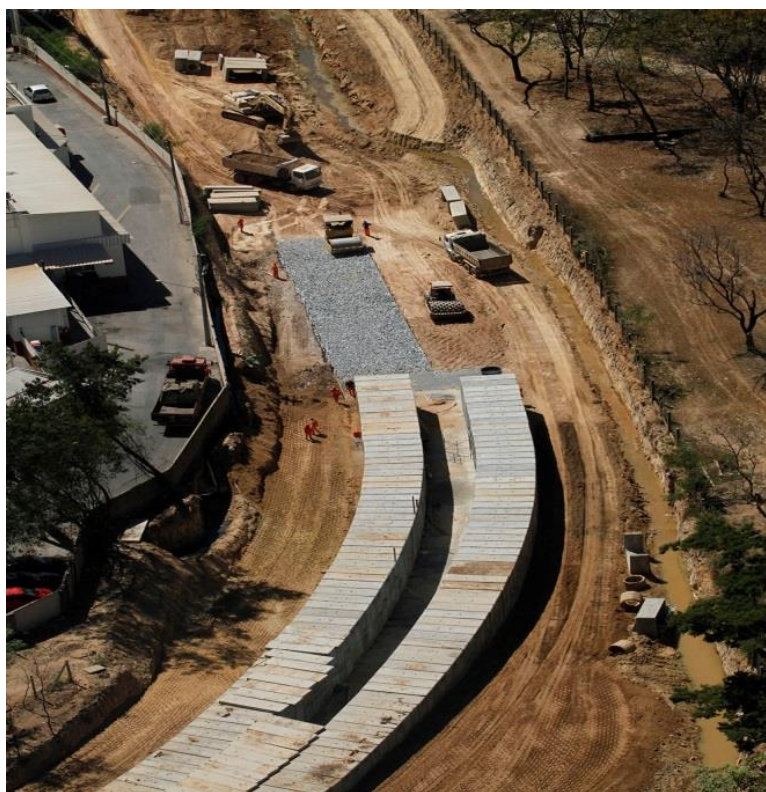
FIGURA 7: Canalização do Córrego. Fonte: RM Cuiabá (MT) | Infraestrutura e Transporte.
