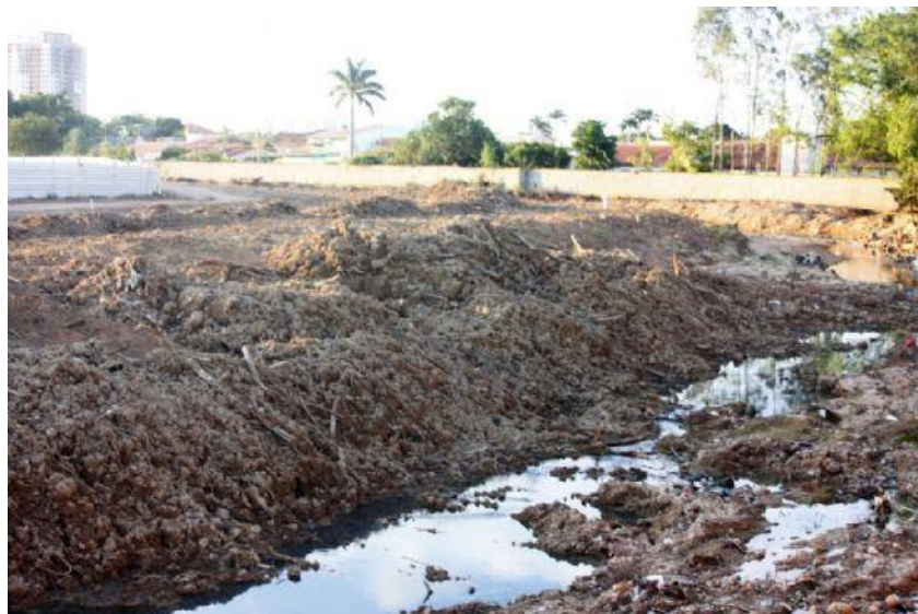
FIGURA 8: Movimentação de terra. Fonte: Site Olhar Direto/Copa
