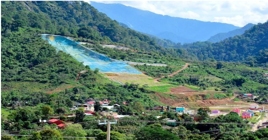
FIGURA 6: Estabilización del Deslizamiento. Fuente: SEDATU (2014)
