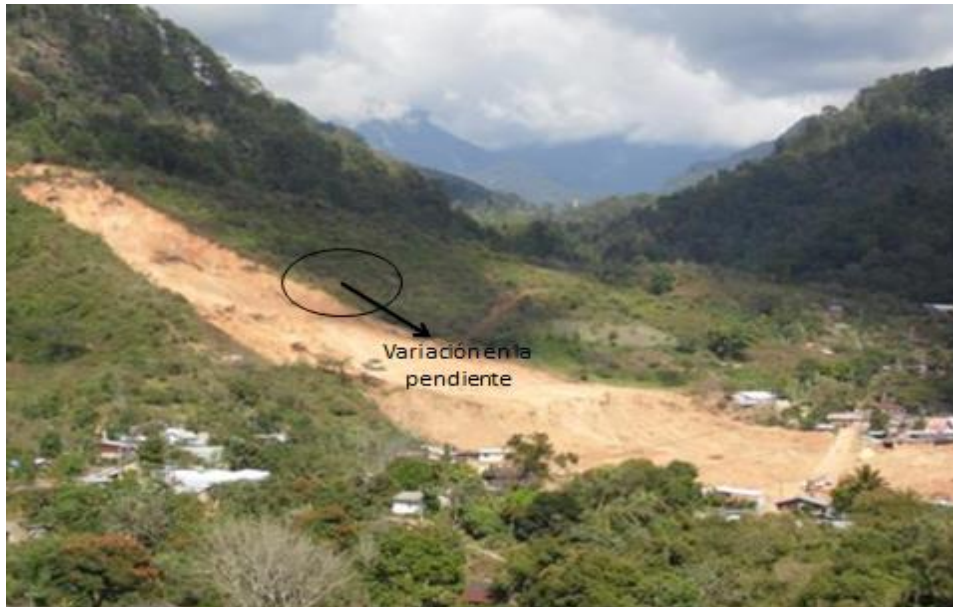
FIGURA 4: Pendientes del derrumbe. Fuente: SEDATU (2014)
