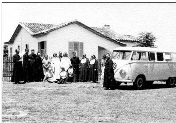
Figura 4: Casa Assistencial da Mineração de Içara (1959)
