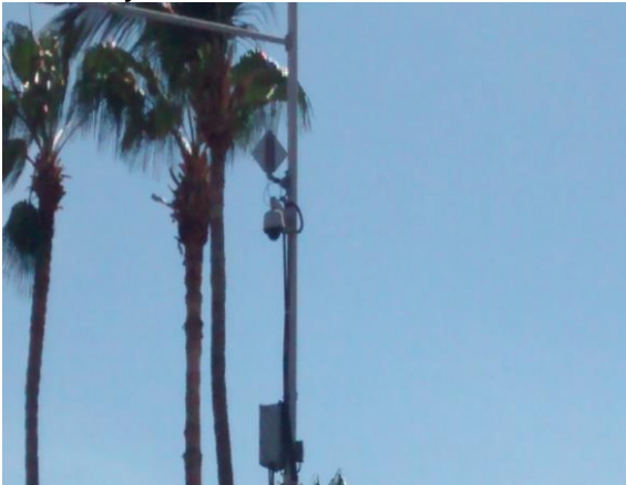
Fig. 2. Cámara en la intersección de Blvd. Lázaro Cárdenas y Ave. Leona Vicario.
