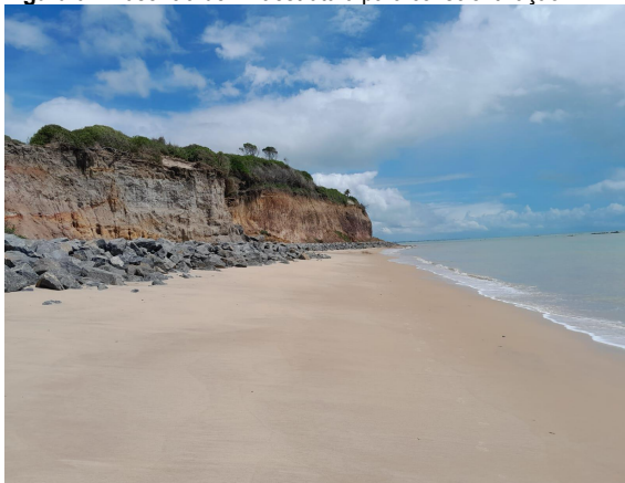
Figura 04. Ausência de infraestrutura para conscientização.
