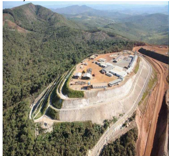
Figura 6: Visão parcial do empreendimento da Mineração.
