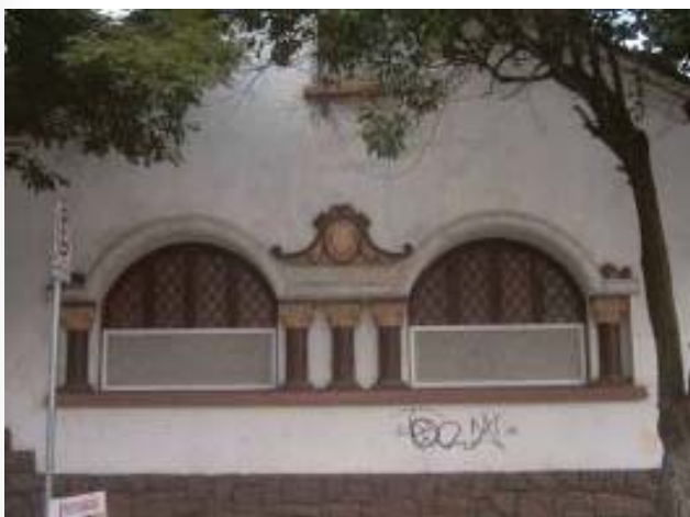
Figura 18 - Detalhe da janela (2008)
