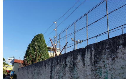
Imagem 6 - Cerca eletrificada com arame farpado (EM02)
