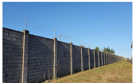
Imagem 8 - Visão oblíqua de um condomínio horizontal a partir da entrada/saída da EM03
