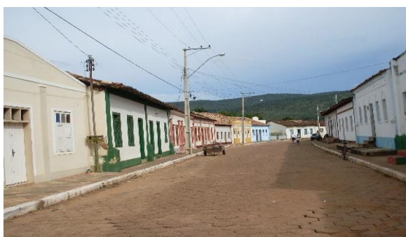
Foto 2 Casarios no Centro Histórico, em Natividade, TO
